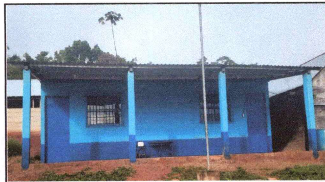
Foto 4: Columnas de concreto sustituyendo las de madera en el patio del establecimiento, puertas instaladas.
