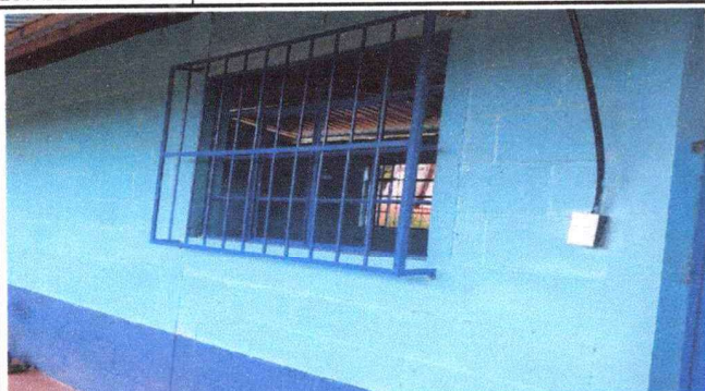
Foto 1: Ventanas instaladas con vidrios y valcon a medida.
