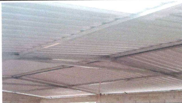
Foto 2: instalacion finalizada de costaneras y laminas.
